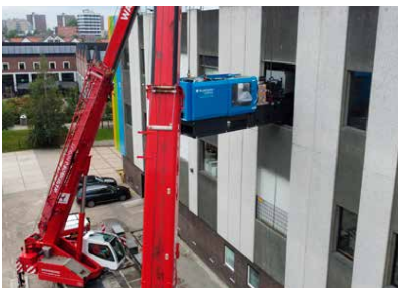
Met twee kranen de elektrische Sumitomo-Demag naar binnen hijsen.
